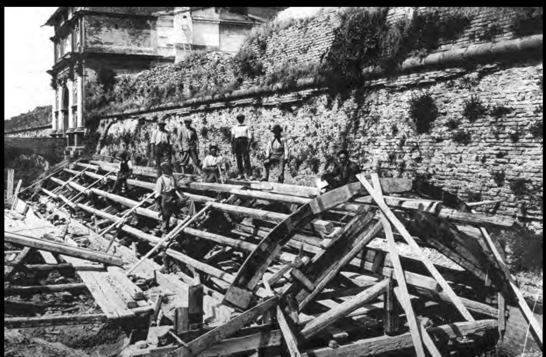
Nel 1928 si costruisce una centina in legno per sostenere la posa di una volta laterizia sopra la fossa Bastioni
