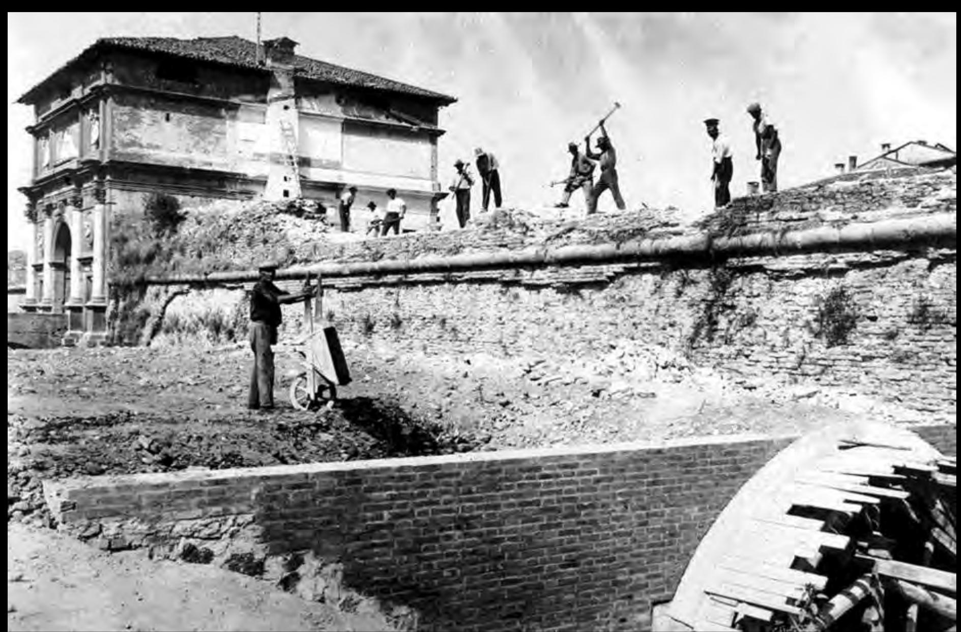
Riempito l'estradosso della nuova volta, inizia la demolizione delle mura per l'apertura della breccia a sud della porta
