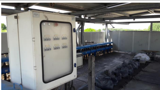
Pannelli schermanti installati lungo la parete sud-ovest
