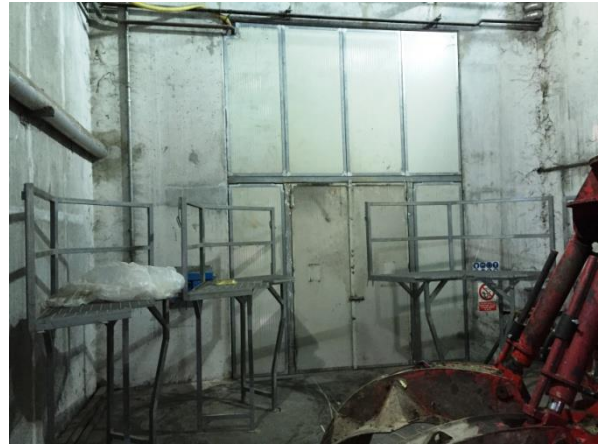
Interno dei locali lato nord: il pannello di separazione tra il locale manutenzione e lo scivolo
