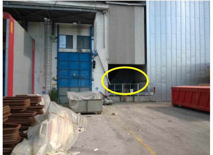
Vista dello scivolo dal piazzale rifiuti
