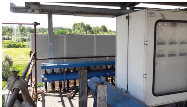
Pannelli schermanti installati lungo la parete sud
