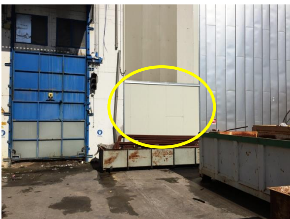
Il pannello installato
