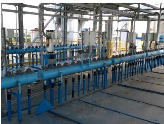
Batteria sfiato pulizia filtri a maniche linea 1 prima dell'intervento di coibentazione
