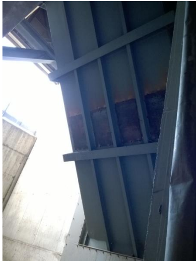
Scivolo trasbordo rifiuti fossa 3 verso la fossa 1-2 prima dell'intervento di posa dei pannelli
