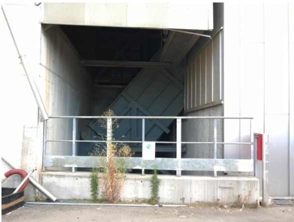
Particolare dello scivolo visto dal piazzale rifiuti
