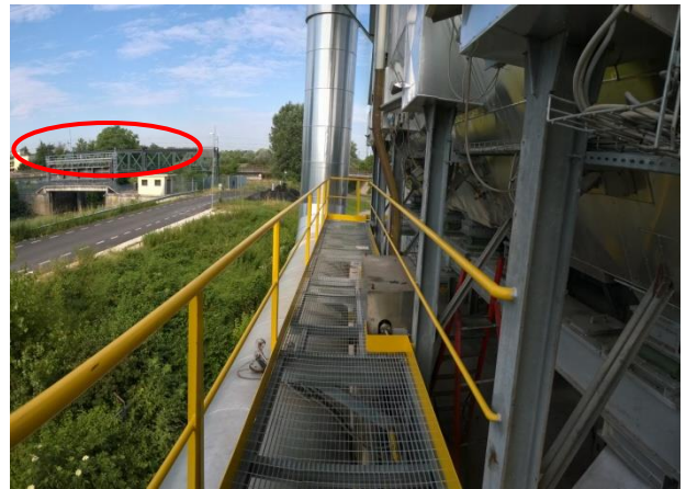
A destra gli scuotitori filtro a maniche linea 1 lato sud: in lontananza si possono individuare i recettori sud
