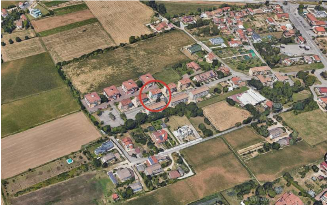
Figura 3 - Area di intervento: in rosso unità in via Pizzamano 34
