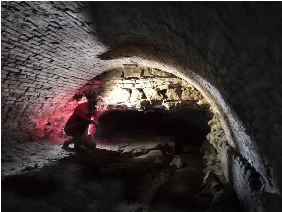
Figura 17-Immagini interne della galleria in prossimità del muro duecentesco
