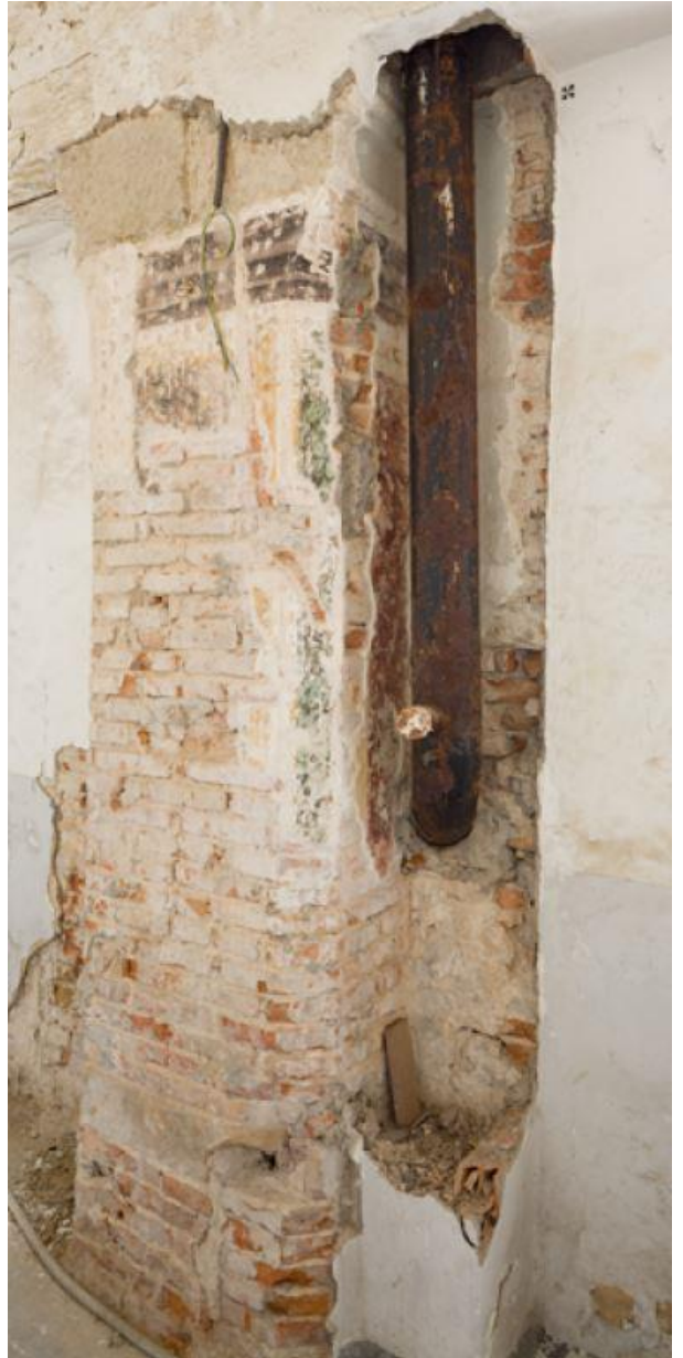
Dettaglio di un pilastro smussato al piano terra della loggia, Padova, Castello Carrarese, ala Est
