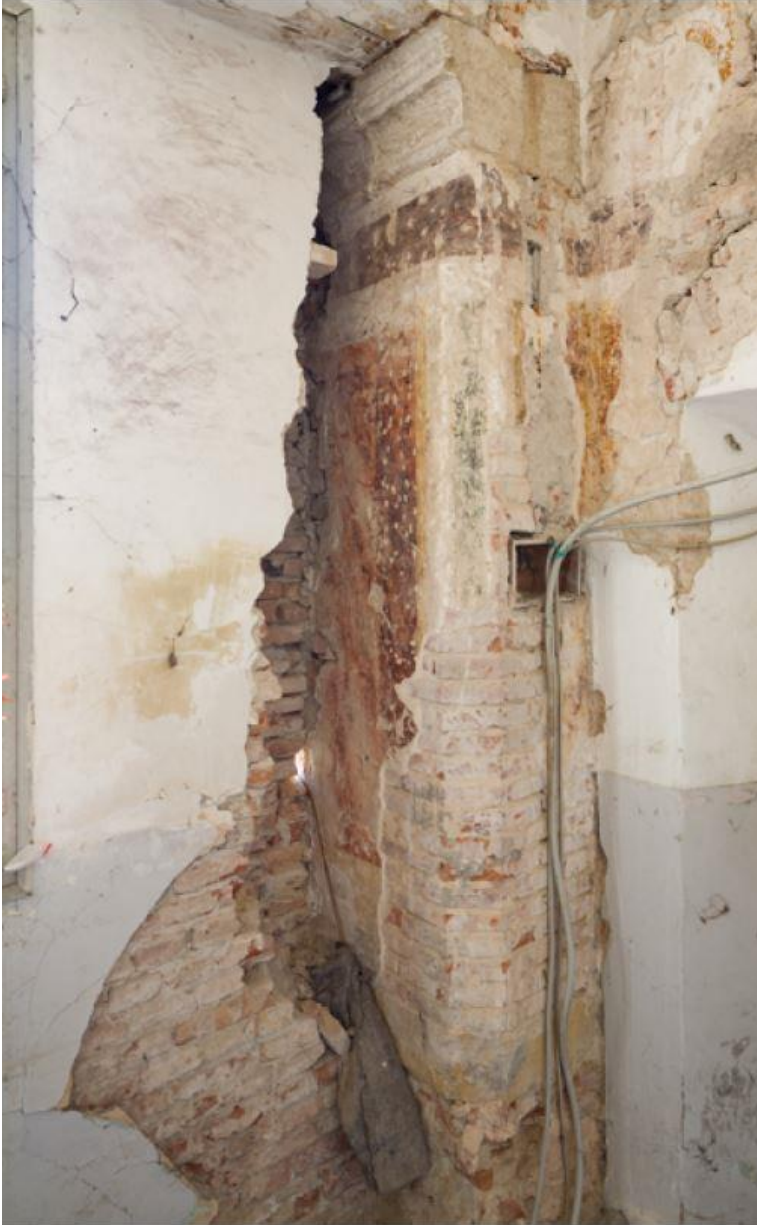
Dettaglio di un pilastro smussato al piano terra della loggia, Padova, Castello Carrarese, ala Est
