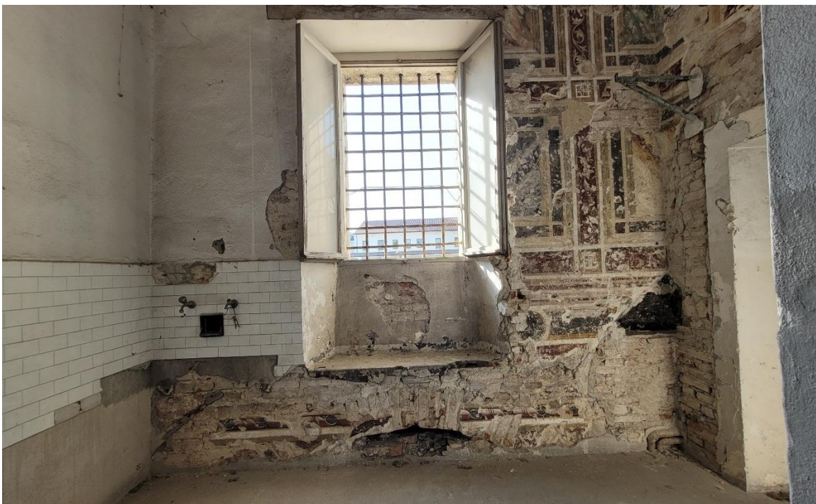
Piano primo della loggia, Padova, Castello Carrarese, ala Est
