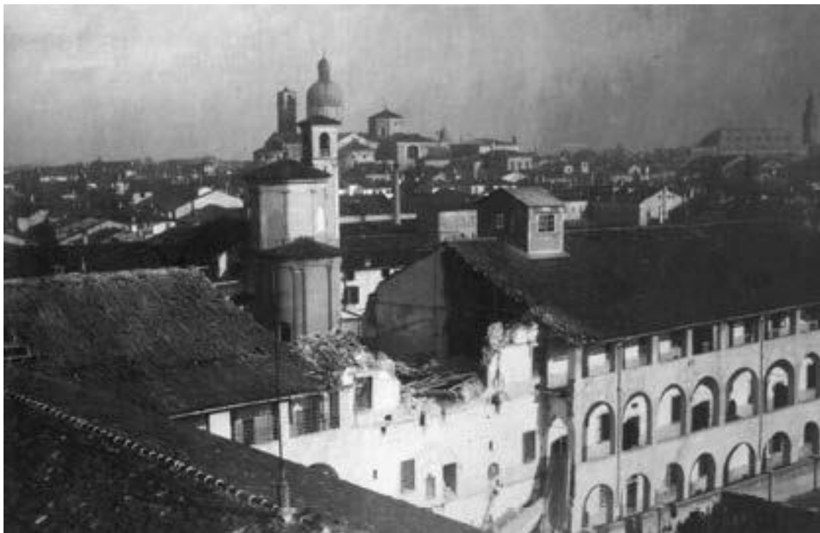
L'ala settentrionale del Castello in seguito al bombardamento austriaco del 5 febbraio 1918
