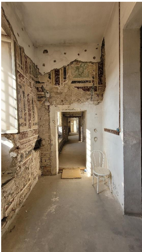
Piano primo della loggia, Padova, Castello Carrarese, ala Est
