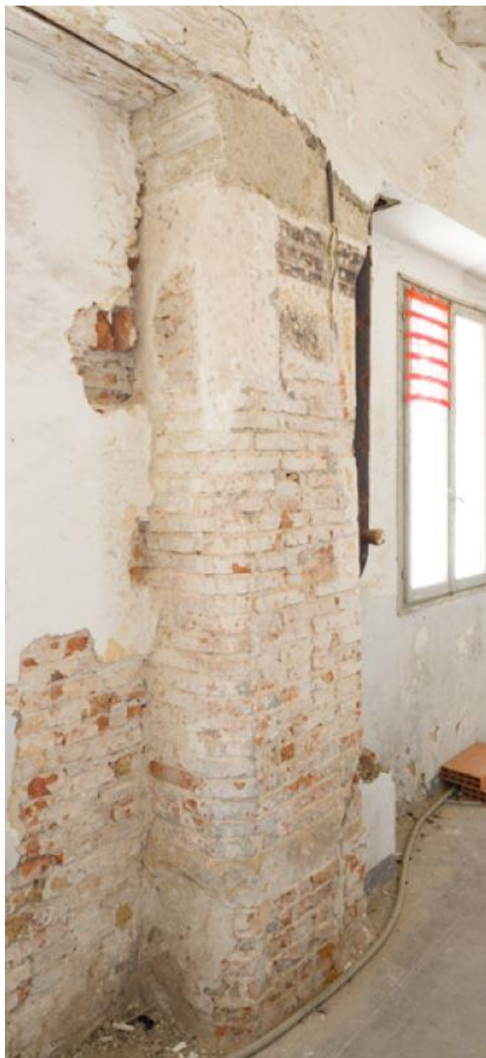
Dettaglio di un pilastro smussato al piano terra della loggia, Padova, Castello Carrarese, ala Est
