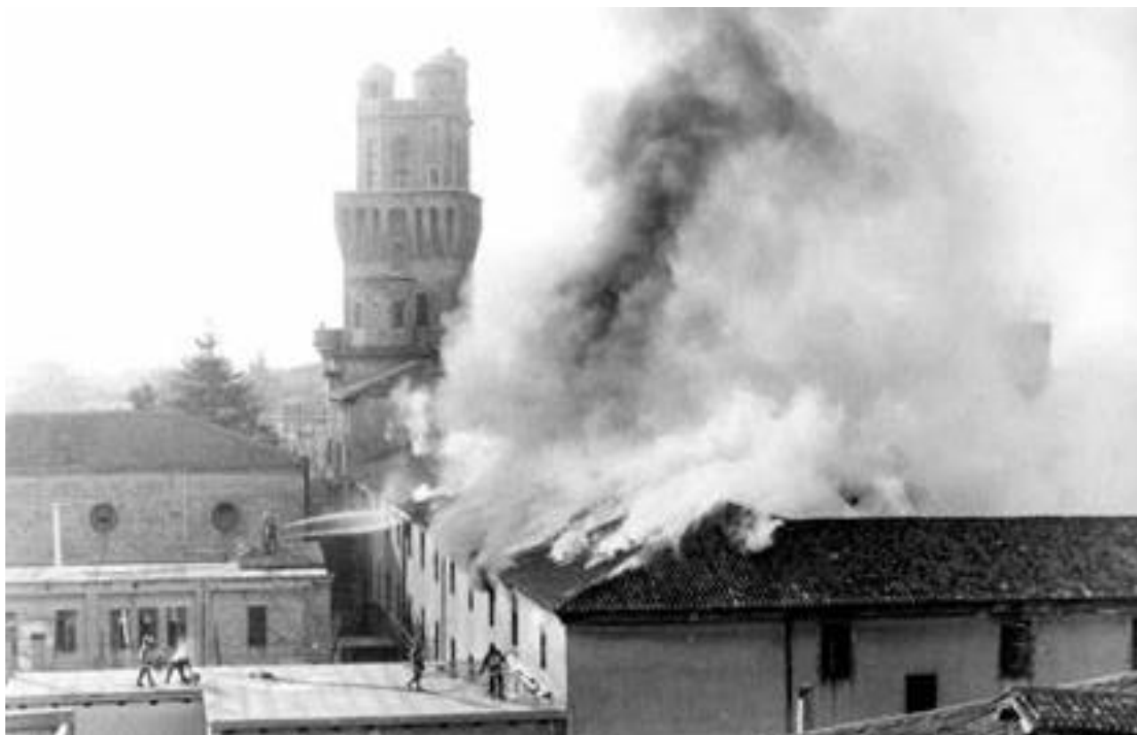
L'ala meridionale del Castello durante l'incendio del 3 febbraio 1989
