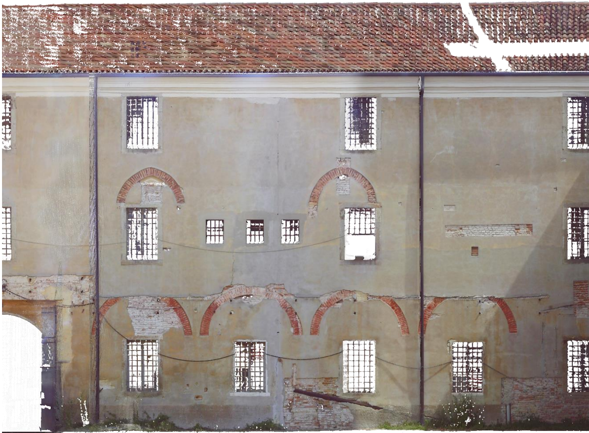
Dettaglio del prospetto prospiciente la corte maggiore, Padova, Castello Carrarese. In evidenza le quattro arcate che costituivano l'antica loggia.
