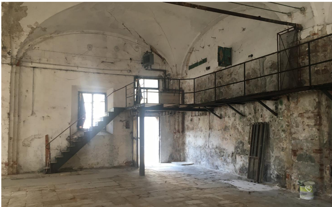
Figura 30 - Vano 00.13, ripresa 20, soppalco metallico.
