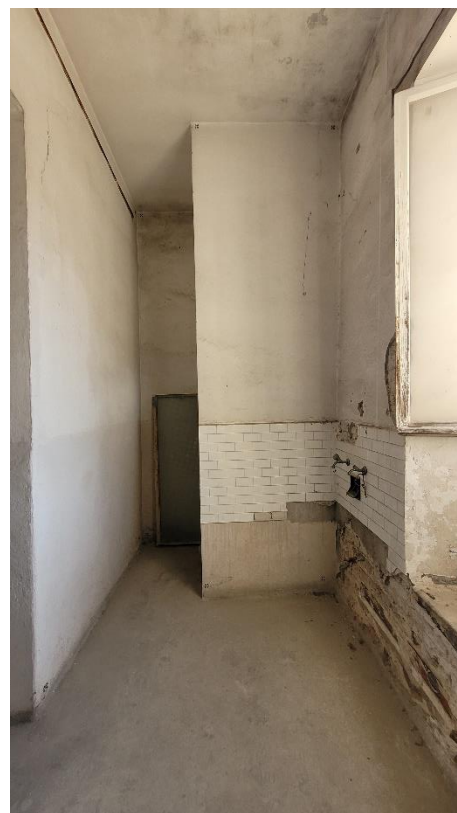
Figura 84 - vano 01.07.b, ripresa 72.
