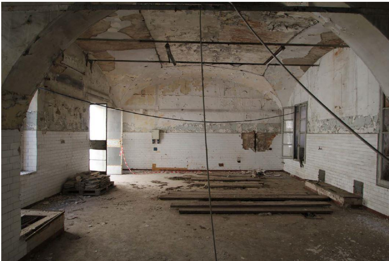
Figura 36 - Vano 00.17.b, ripresa 26, vista da vano adiacente.
