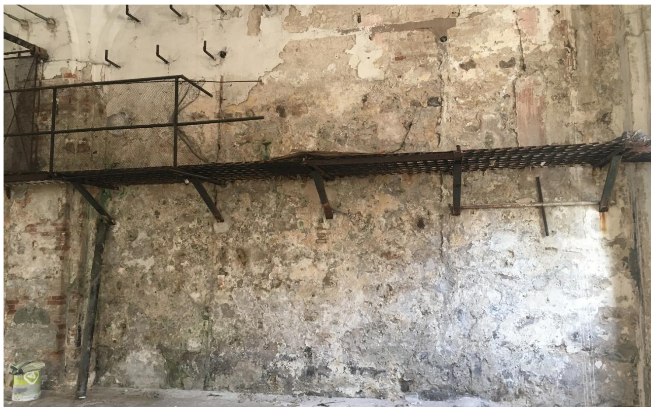
Figura 31 - Vano 00.13, ripresa 21, particolare del soppalco metallico.
