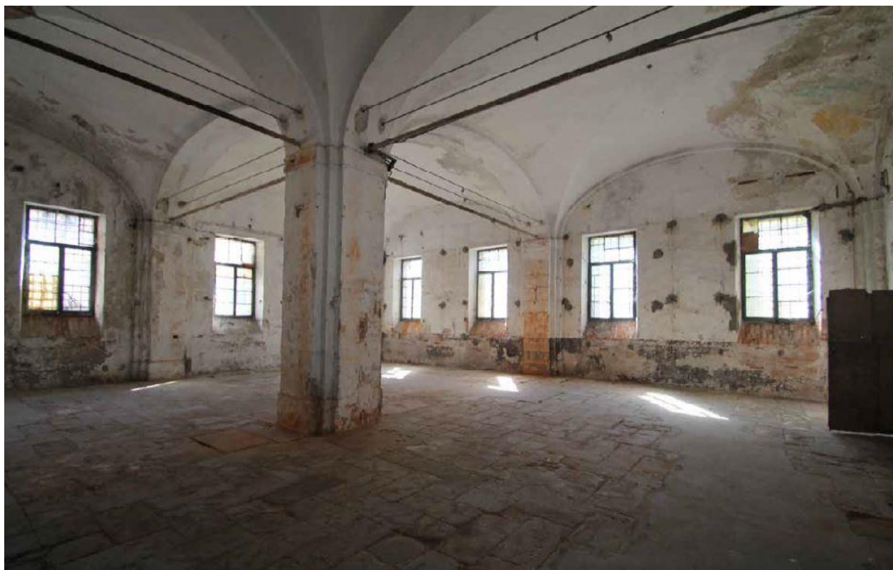
Figura 33 - Vano 00.13, ripresa 23, vista d'insieme.
