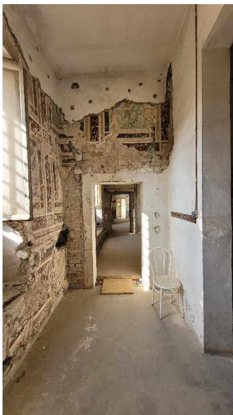
Figura 83 - Vano 01.07.b, ripresa 71.
