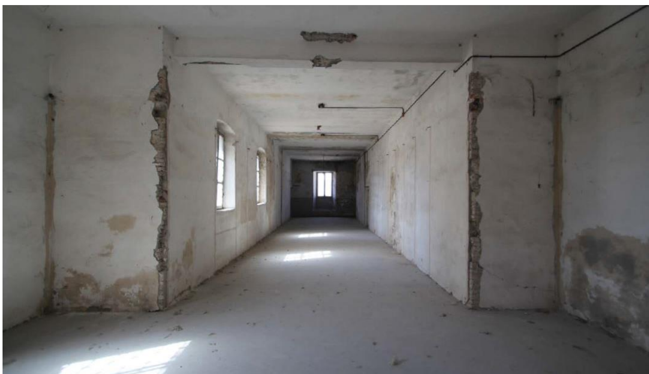
Figura 77 - Vano 01.04, ripresa 66 da vano 01.05.
