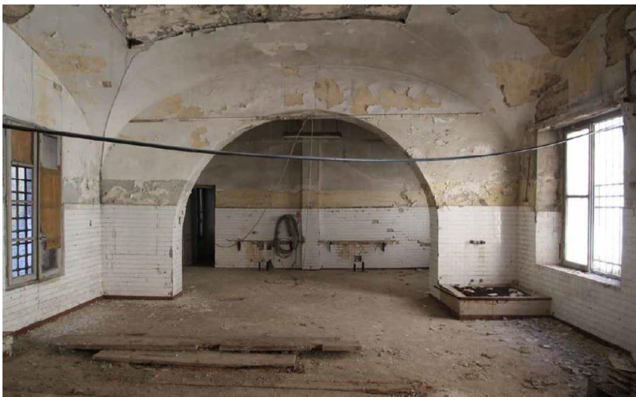
Figura 34 - Vano 00.17.b, ripresa 24, vista verso vano 00.16.
