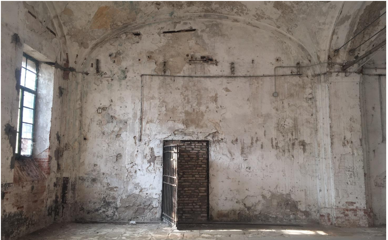
Figura 29 - Vano 00.13, ripresa 19, porta tamponata.
