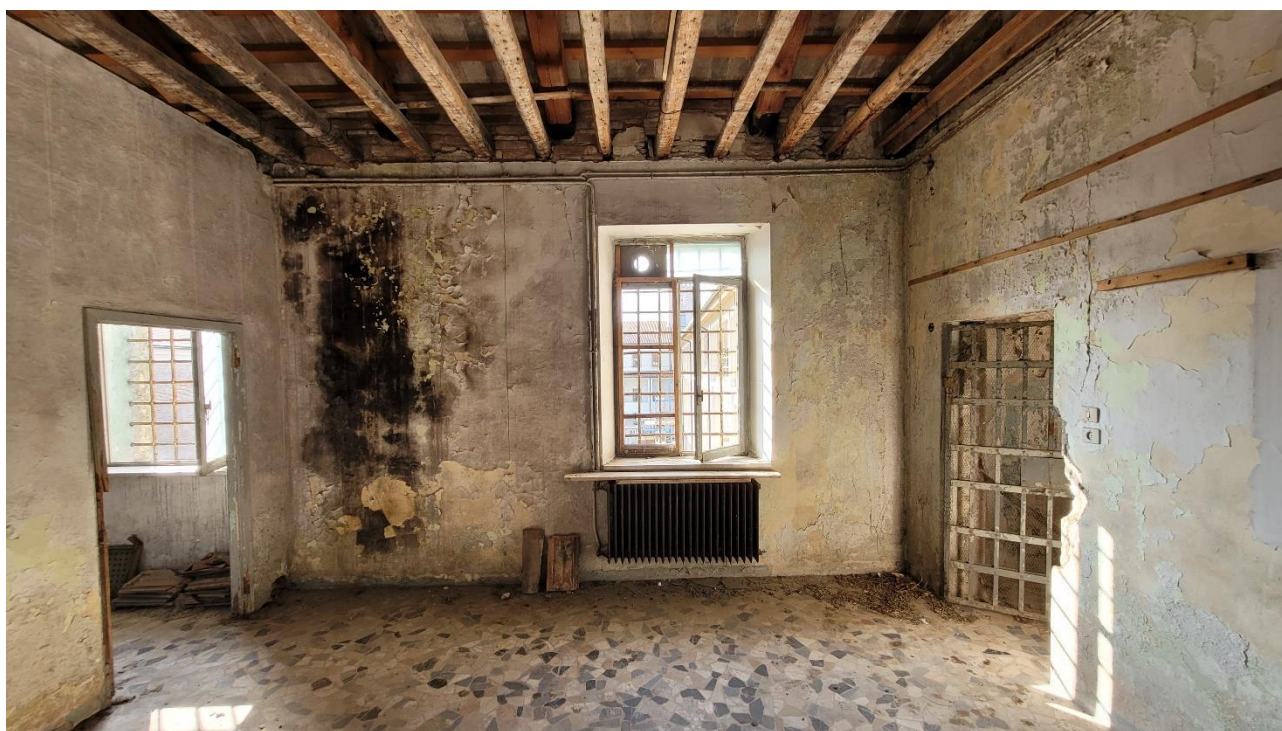
Figura 100 - Vano 02.03.b, ripresa 87.
