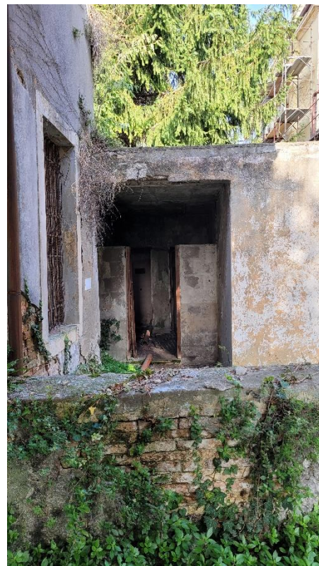
Figura 49 - Vano 00.22, ripresa 39 verso vano 00.28.
