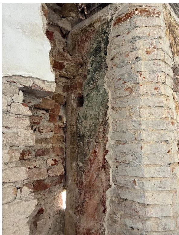
Figura 26 - Vano 00.09, ripresa 16, pilastri inglobati nella muratura.
