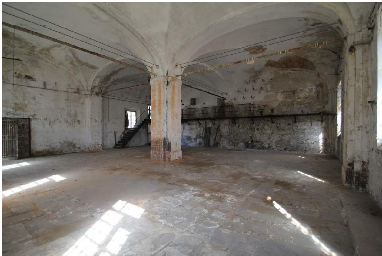
Figura 32 - Vano 00.13, ripresa 22, vista d'insieme.
