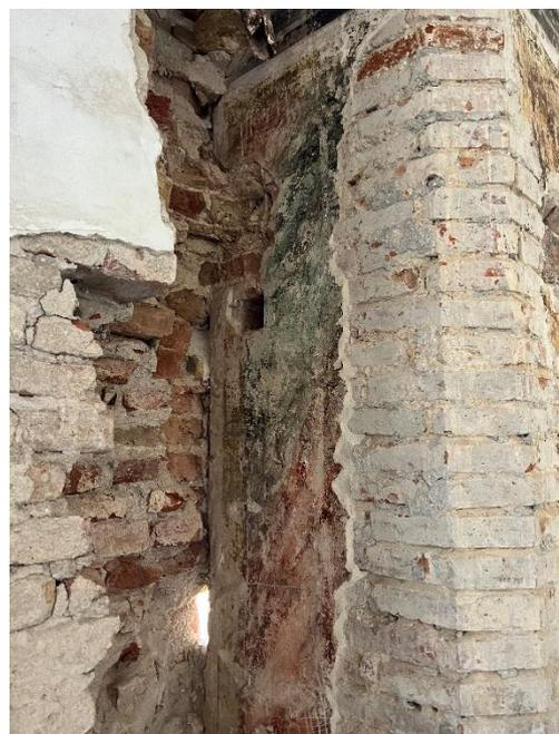
*Figura 3- Porzione di muratura da eliminare per dare continuità alla parete affrescata; rimessa in vista della superficie decorata dei pilastri*
