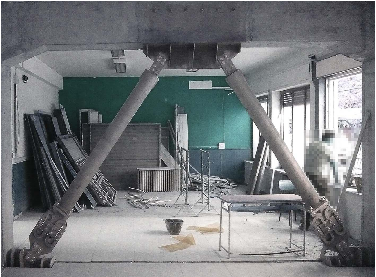
Installazione di controventi dissipativi
