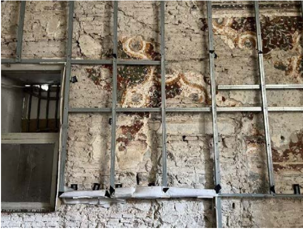
Figura 8 - Struttura metallica sopra i lacerti di affresco.
