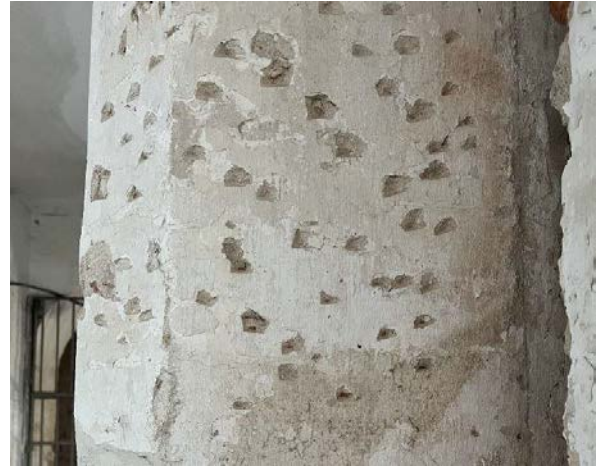
Figura 9 – Intonaco picchettato e con scialbatura.
