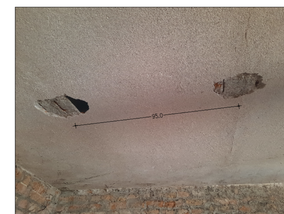
SONDAGGIO 4 SOLAIO rapp. 1:10
