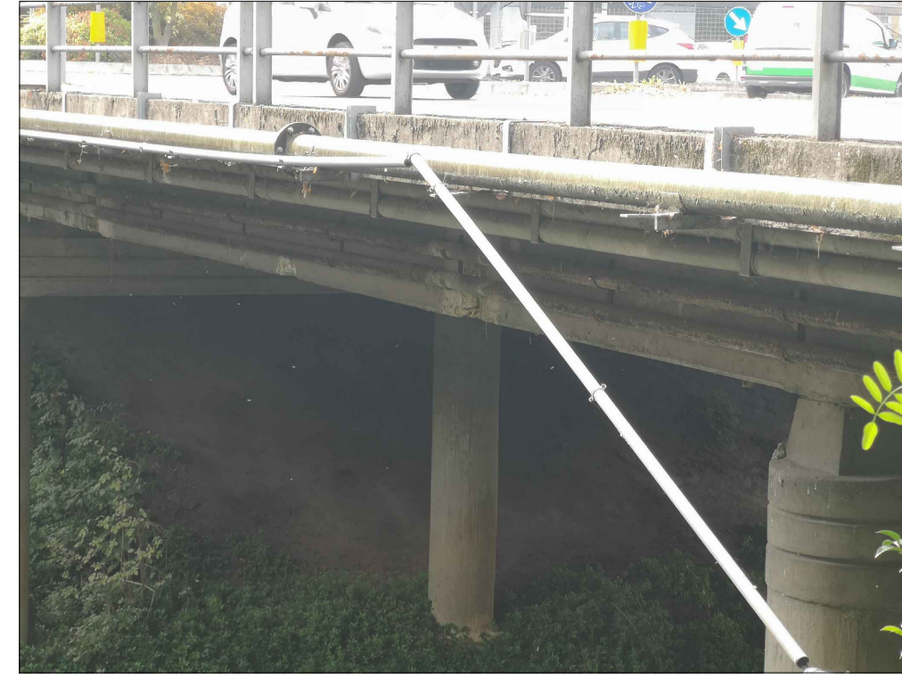
FOTO 3 Sottoservizi lato Est
