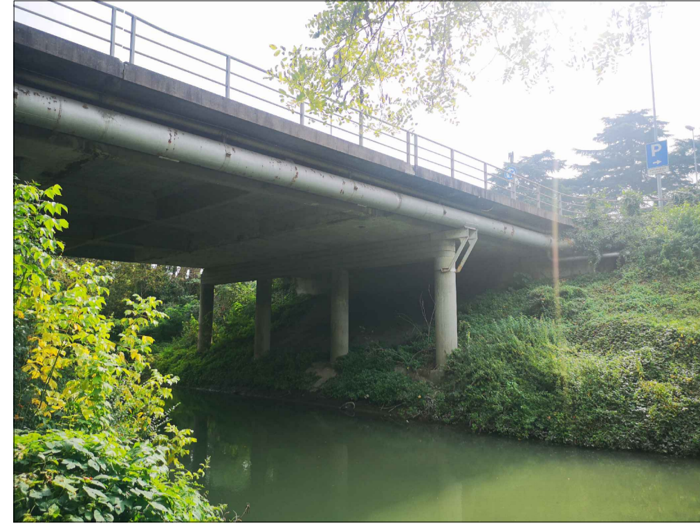
FOTO 4 Sottoservizi lato Ovest
