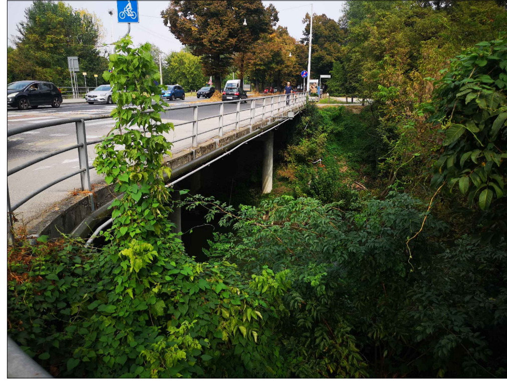
FOTO 1 Vista da Sud
