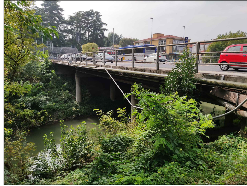
FOTO 2 Vista da Nord
