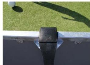
I pali sono realizzati con profilo 80 x 80 x 3 mm con flange saldate orizzontalmente da 6 mm. Ciò consentirà un'installazione facile e una costruzione robusta. I cappucci dei pali in polietilene a bassa densità sono fissati con rivetti ciechi.
