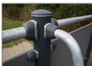
I connettori sono realizzati in alluminio pressofuso, appositamente legati per gli ambienti esterni e l'uso intenso. Le viti che fissano i connettori sono in acciaio inossidabile protette da rondelle di zinco.
