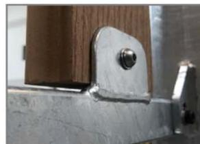
Le schede WPC sono fissate a flange saldate 70 x 45 x 3 mm con bulloni, dadi e rondelle M8 in acciaio inossidabile. Queste connessioni non sono visibili dall'interno e creano una connessione forte e sicura.
