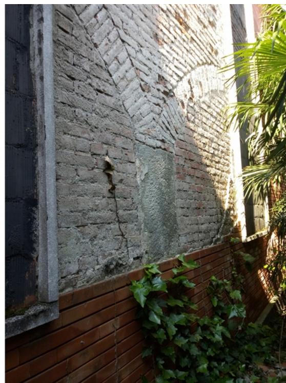
18_FACCIATA SUD DELLA CORTE: DISTACCO DEL PARAMENTO E STRUTTURE DELLA BARCHESSA ORIGINARIA
