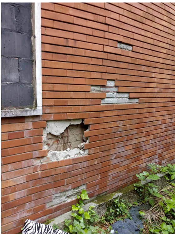
18_FACCIATA SUD DELLA CORTE: DISTACCO DEL PARAMENTO E STRUTTURE DELLA BARCHESSA ORIGINARIA
