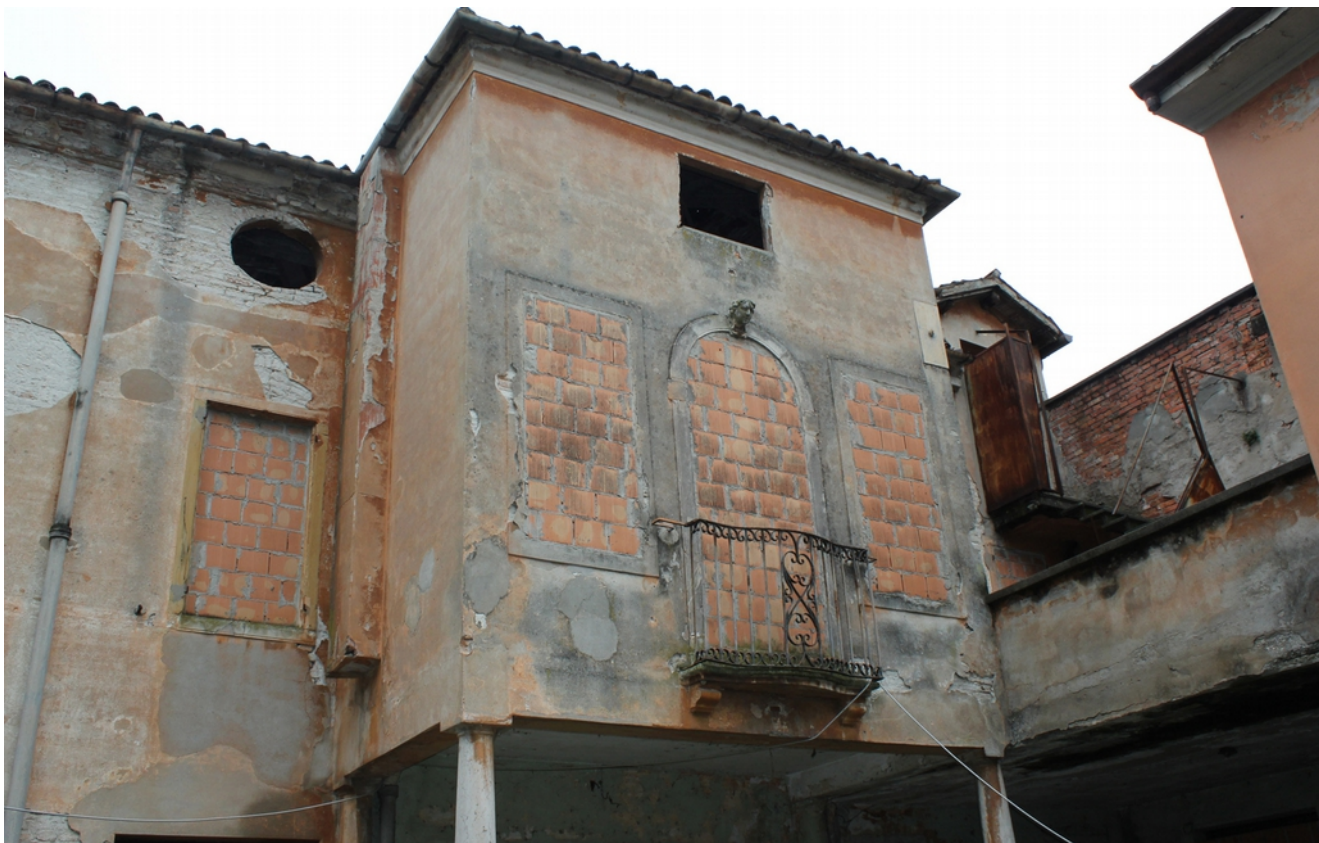
57_FACCIATA DELLA VILLA, L'AVANCORPO
