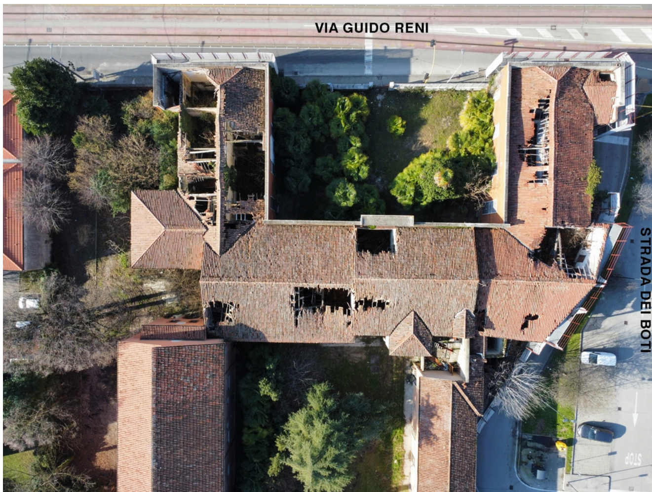
11_FOTOGRAFIA DELLO STATO ATTUALE DELLE COPERTURE DAL DRONE
