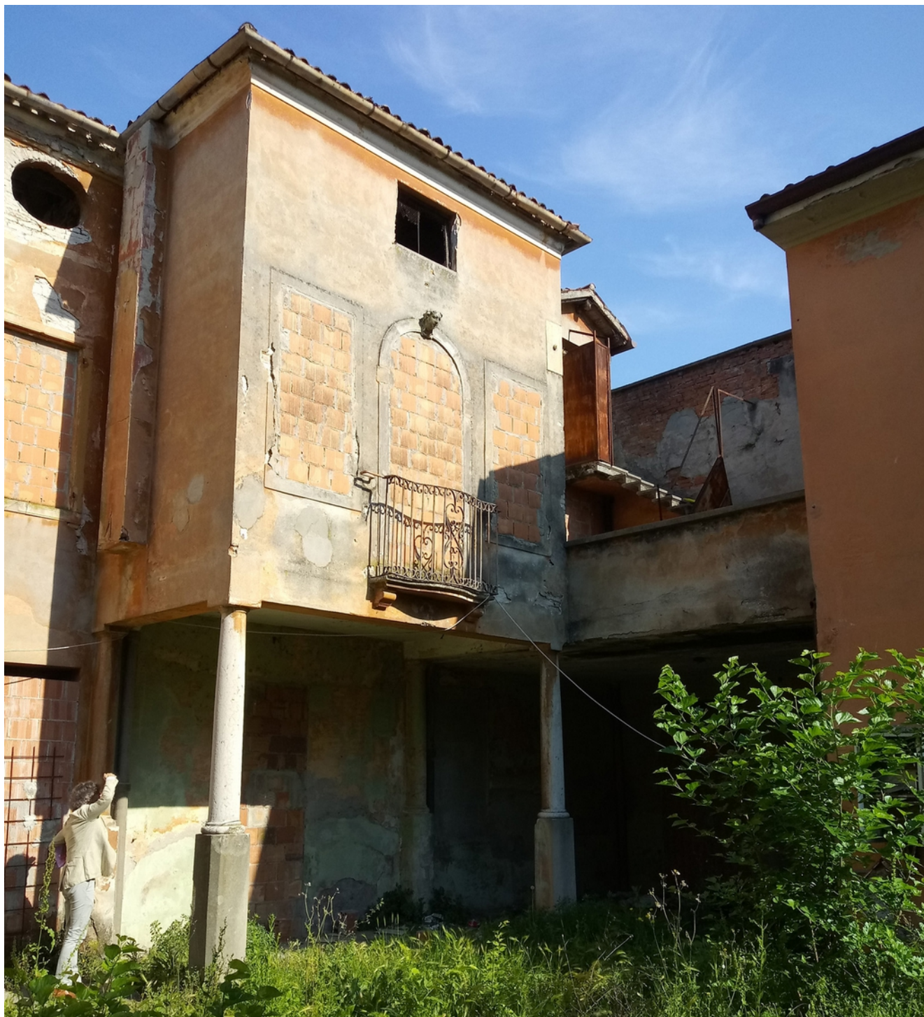
21_PARTICOLARE DEL CORPO IN AGGETTO; A DESTRA LA TERRAZZA DI COLLEGAMENTO CON L'ANNESSO
