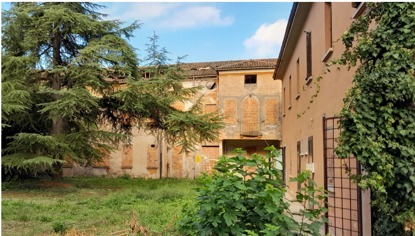
20_LA FACCIATA POSTERIORE DELLA VILLA
