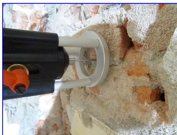
Particolare indagine P1
