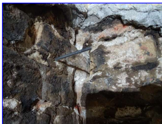
Particolare indagine P4
