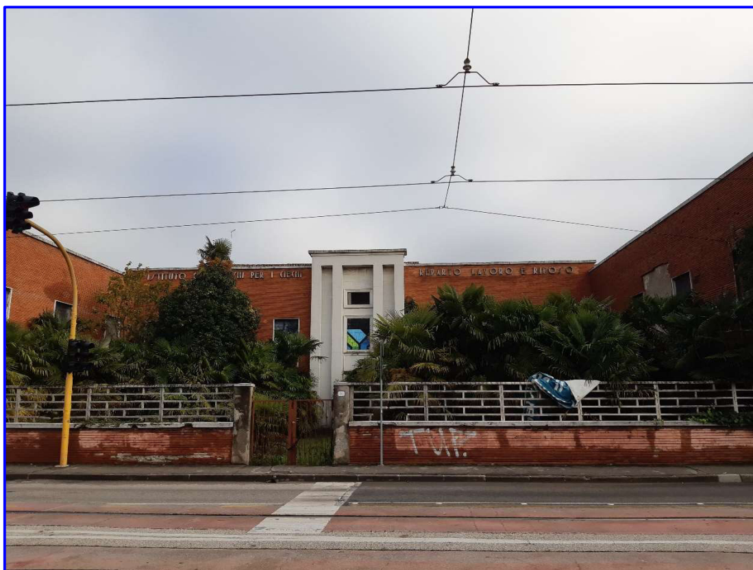
Prospetto edificio da via Guido Reni - Padova
