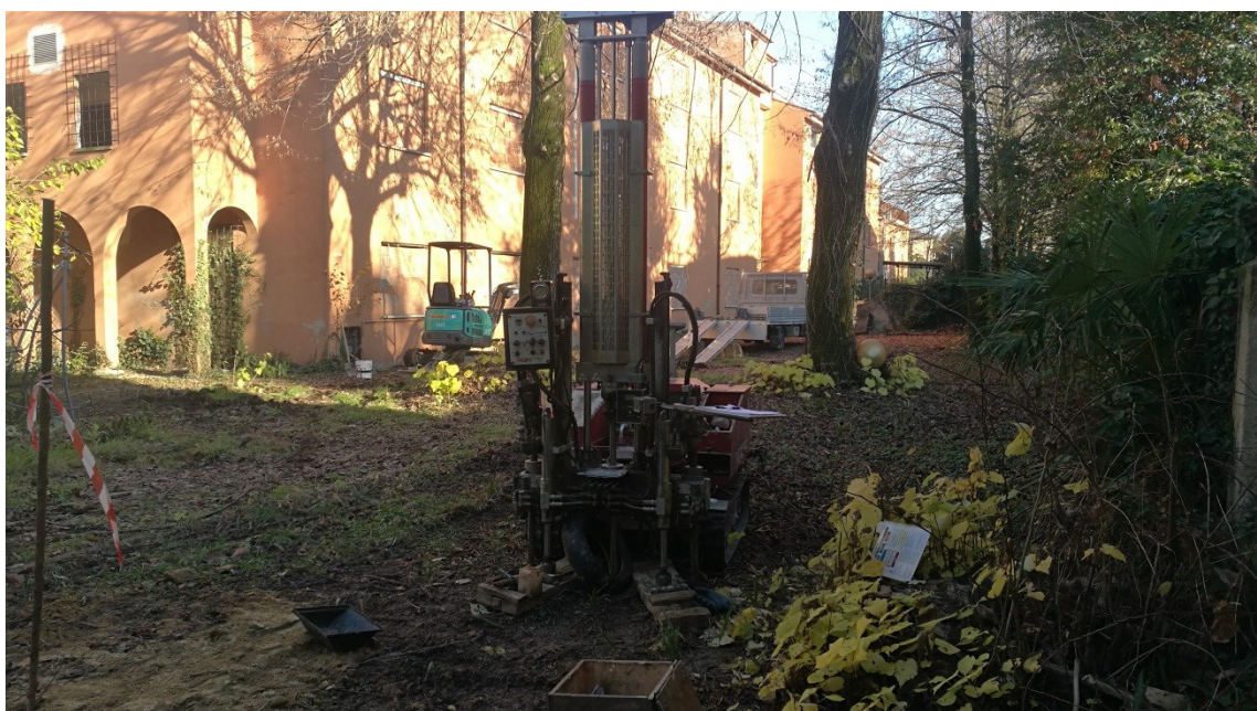
Fig. 2- Esecuzione prova CPT2.
