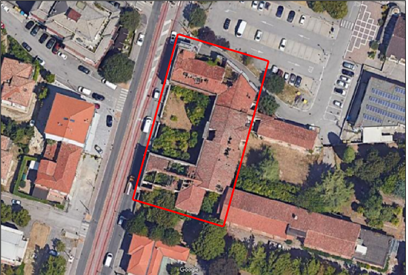
Estratto fotografico aereo per l'identificazione del fabbricato in esame
