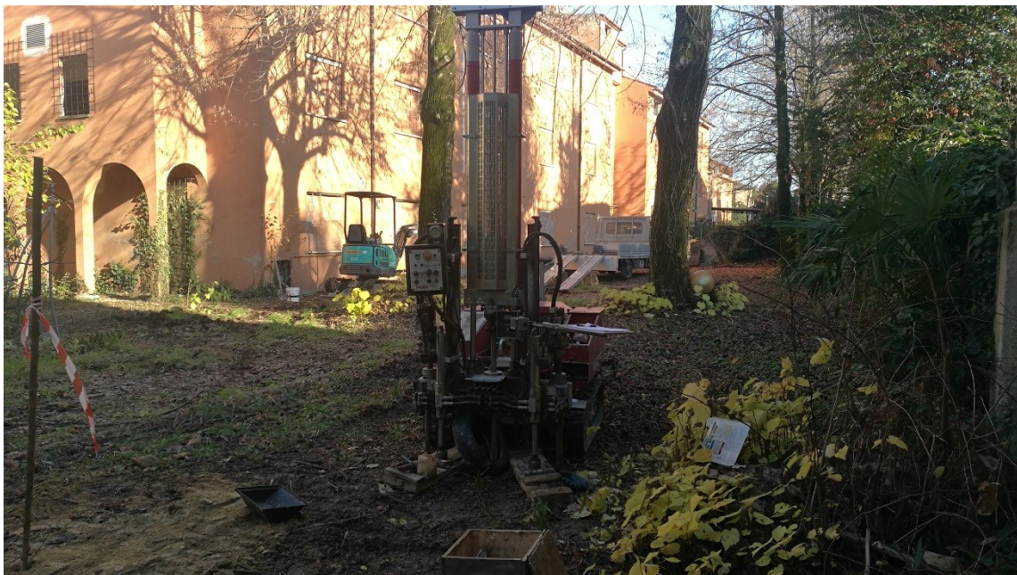
Fig. 2- Esecuzione prova CPT2.
