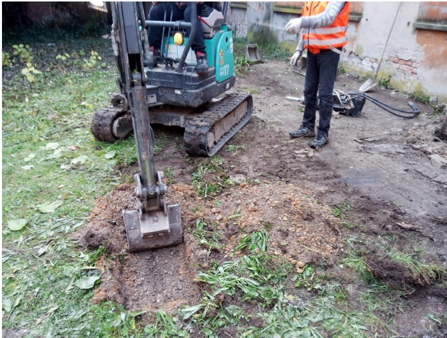
Fig. 1 - Esecuzione trincea TR1.
