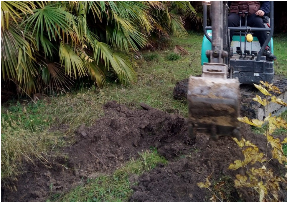
Fig. 5 - Esecuzione trincea TR3.
