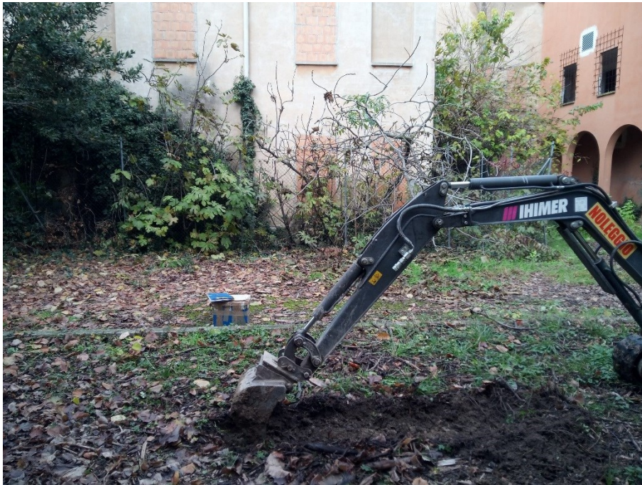
Fig. 3 - Esecuzione trincea TR2.
