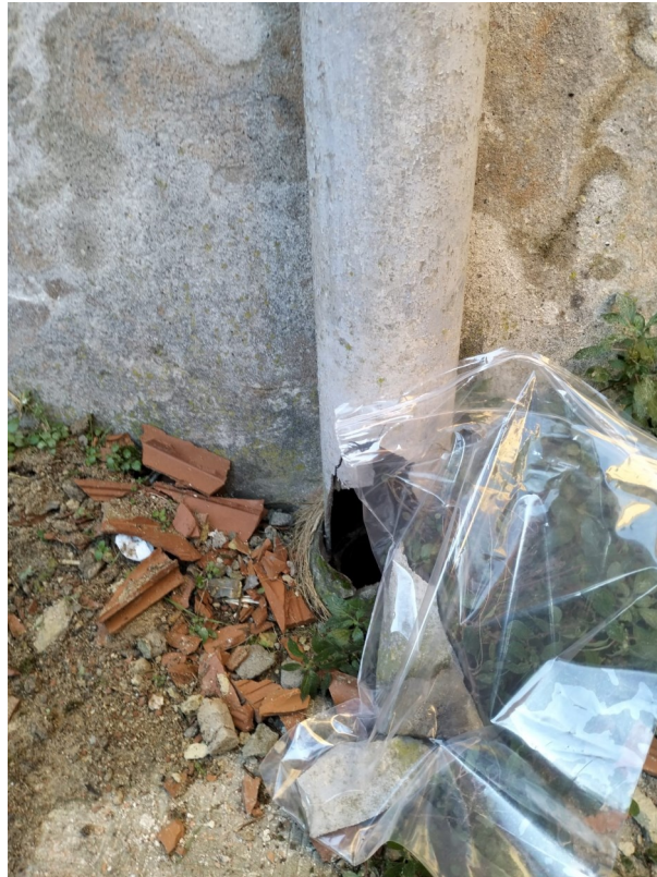
Fig.5- Punto di campionamento 5, esterno edificio.
