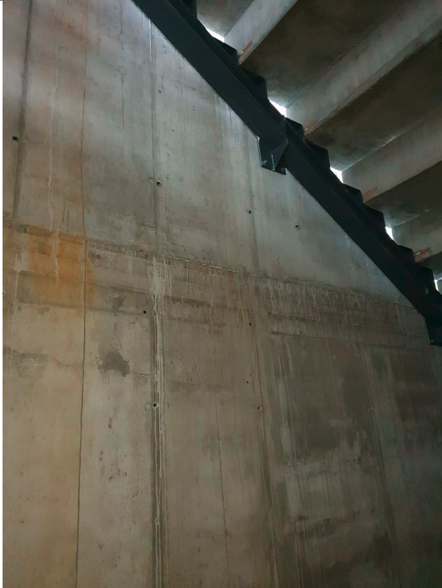
Fig. 5: Foto cantiere attuale sotto tribuna (trave porta gradone)
