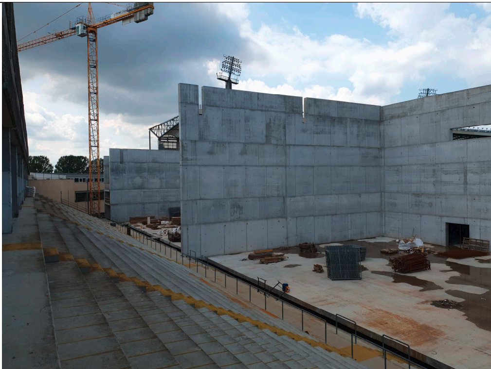
Fig. 4: Foto cantiere attuale lato palestre sud
