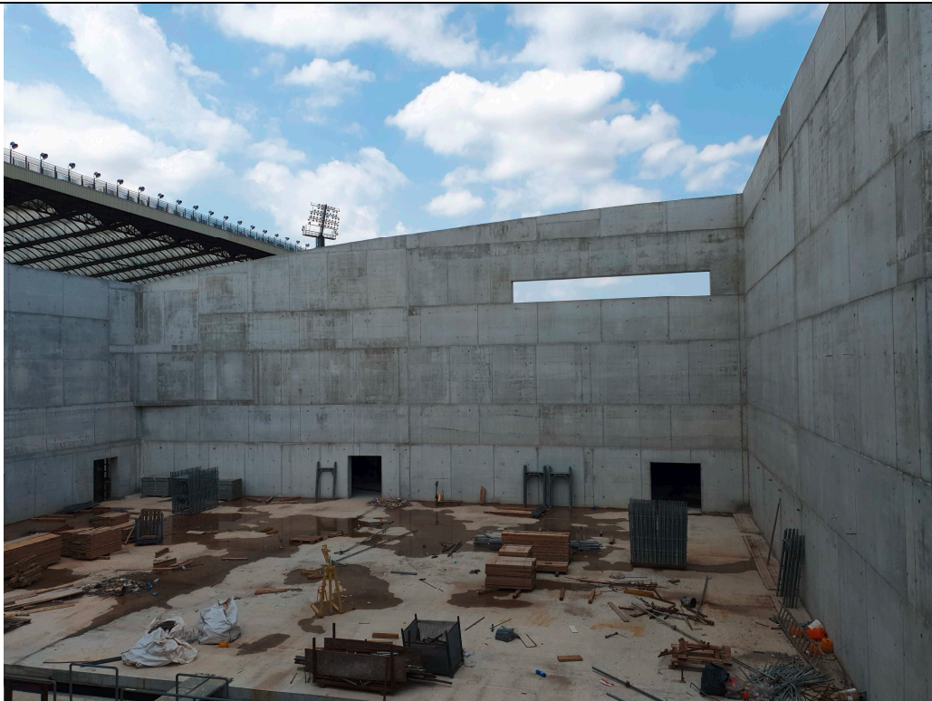
Fig. 2: Foto cantiere attuale, lato palestre ovest
