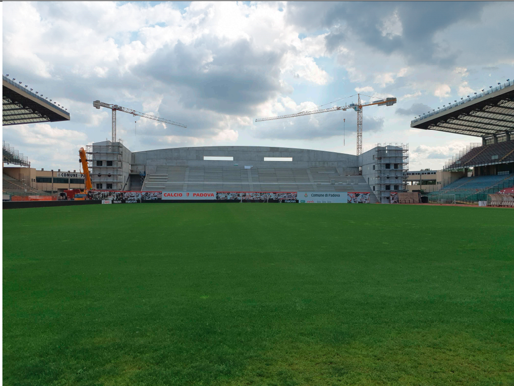
Fig. 1: Foto cantiere attuale, fronte
