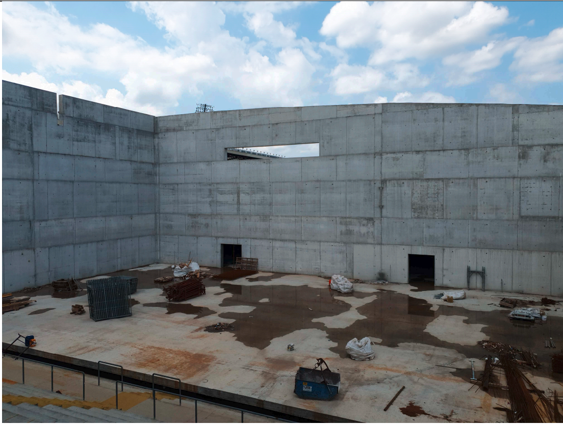
Fig. 3: Foto cantiere attuale lato palestre est
