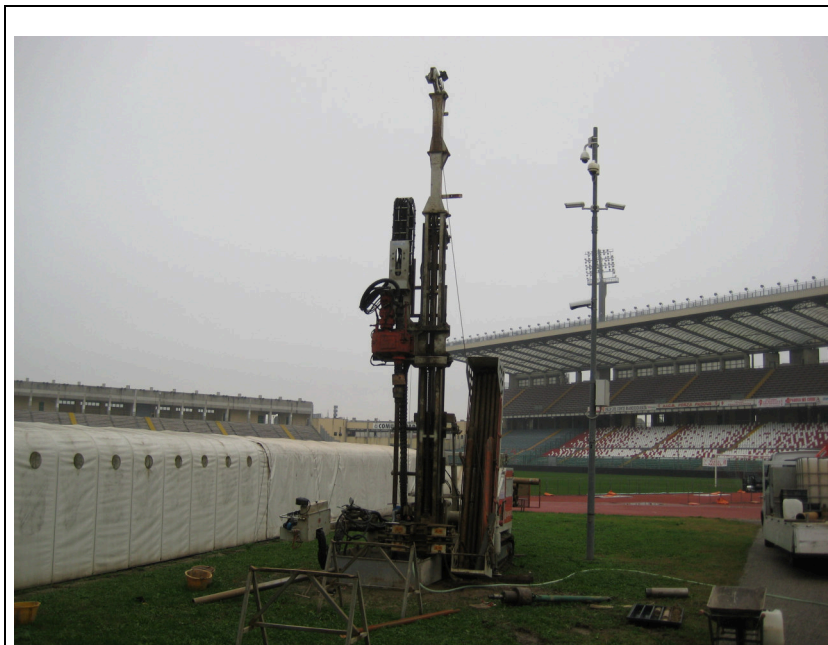
Foto 4: Esecuzione sondaggio S1
