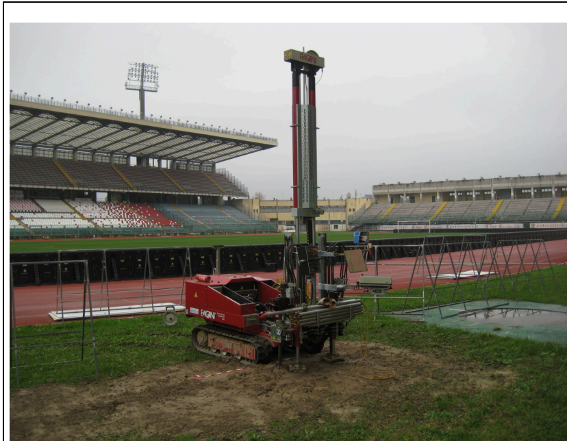
Foto 3: Esecuzione della prova CPTU3
