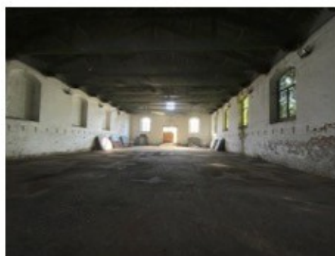
interno verso sud
