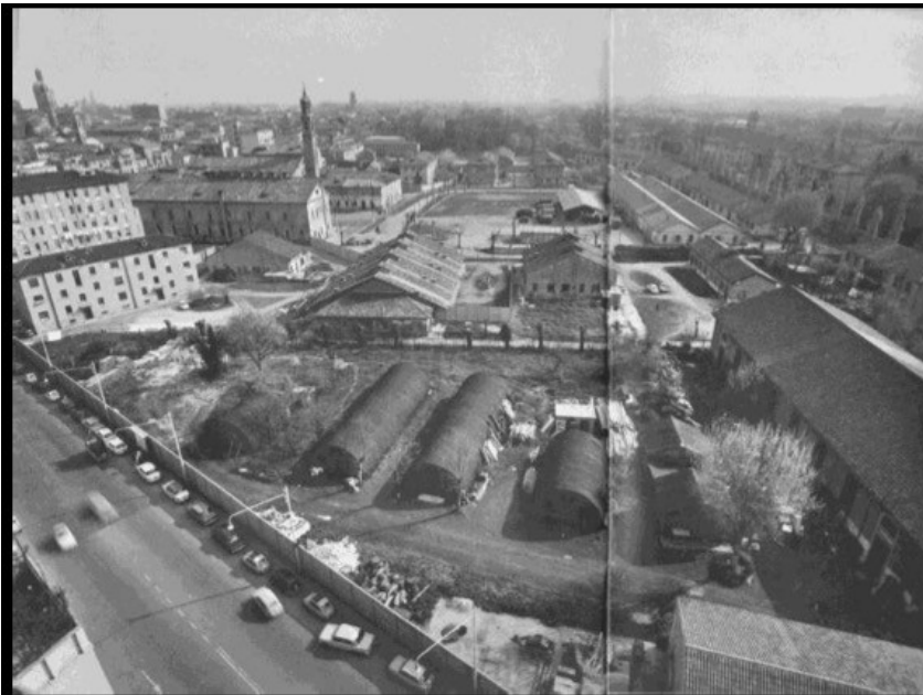
Veduta dall'alto verso sud databile al 1969. Gli hangar semicircolari in primo piano e i due magazzini affiancati in alto a destra lungo via Orsini sono poi stati demoliti
