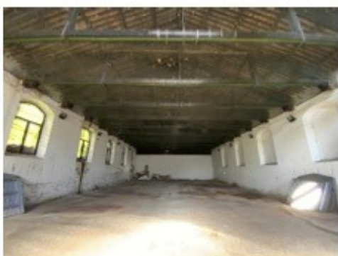
interno verso nord
