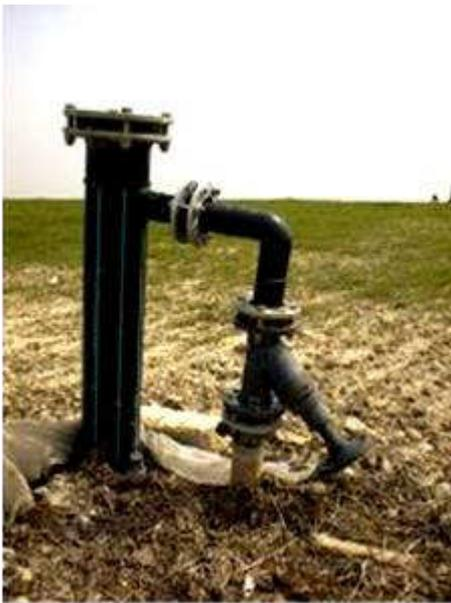
**Figura 30. Particolare dell'impianto di captazione biogas: pozzetto di raccolta.**
