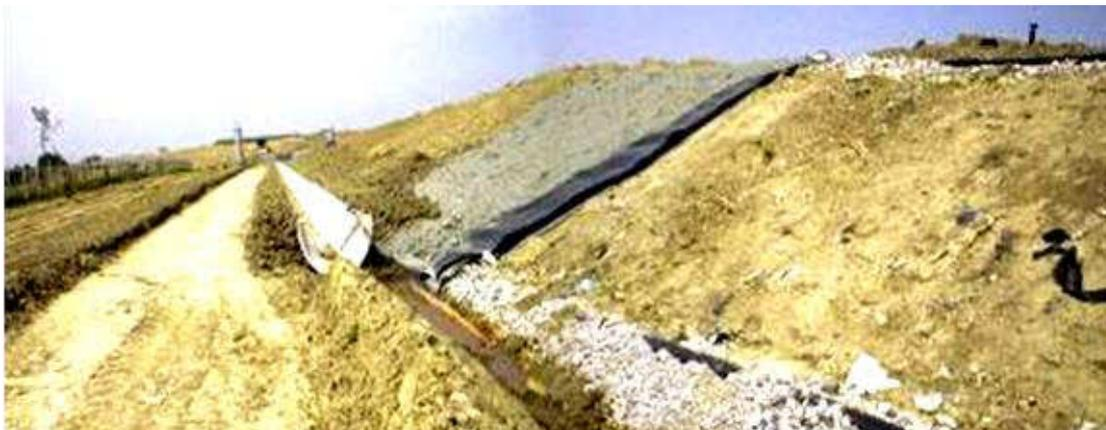
**Figura 26. Particolare di un argine di contenimento di una “vasca” in fase operativa. Si notano il sistema di impermeabilizzazione laterale con materiale HPDE ed argilla e la canaletta perimetrale di contenimento**
