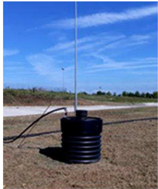
**Figura 31. Particolare dell'impianto di raccolta percolato: pozzo di raccolta.**
