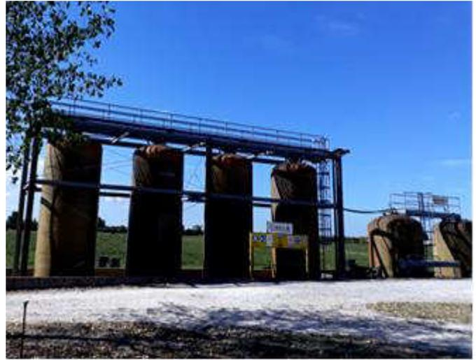
**Figura 29. Particolare dell'impianto di raccolta percolato: cisterne di stoccaggio.**
