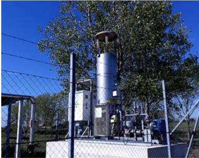
**Figura 28. Particolare dell'impianto di captazione biogas: torcia.**
