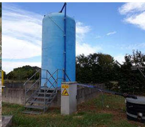
Figura 35. Particolare dell'impianto di raccolta percolato: cisterna di stoccaggio.
