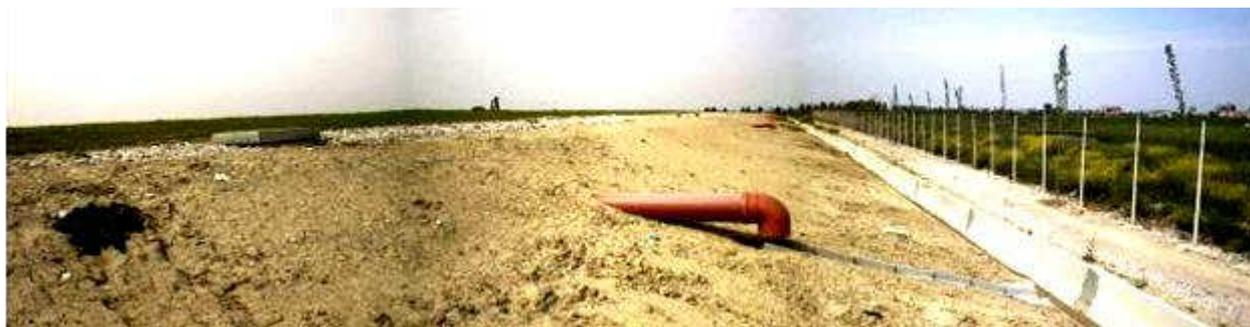
**Figura 27. Particolare del lotto C in fase di ultimazione : fiancata dell'argine di contenimento. Si notano i tubi di scarico delle acque piovane superficiali che provengono dai pozzetti di raccolta inseriti negli inghiottitoi superficiali, la canaletta perimetrale di contenimento delle stesse acque, la pista carrabile perimetrale di controllo, la recinzione e la barriera arborea che delimitano tutta la discarica**
