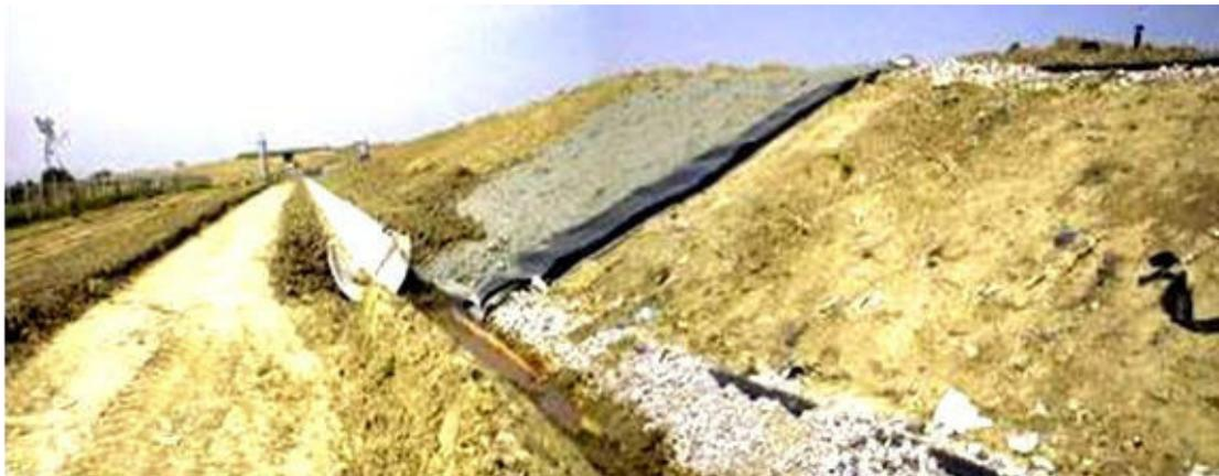
**Figura 21. Particolare di un argine di contenimento di una “vasca” in fase operativa. Si notano il sistema di impermeabilizzazione laterale con materiale HPDE ed argilla e la canaletta perimetrale di contenimento**
