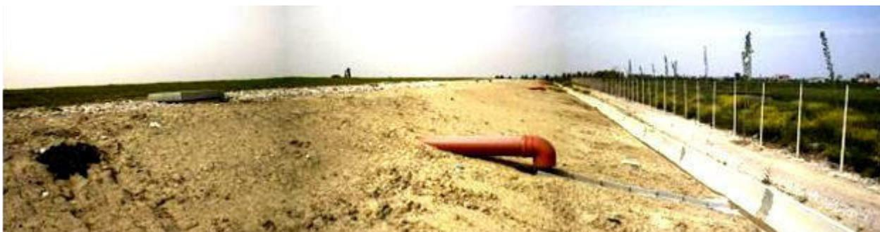
**Figura 22. Particolare del lotto C in fase di ultimazione : fiancata dell'argine di contenimento. Si notano i tubi di scarico delle acque piovane superficiali che provengono dai pozzetti di raccolta inseriti negli inghiottitoi superficiali, la canaletta perimetrale di contenimento delle stesse acque, la pista carrabile perimetrale di controllo, la recinzione e la barriera arborea che delimitano tutta la discarica**
