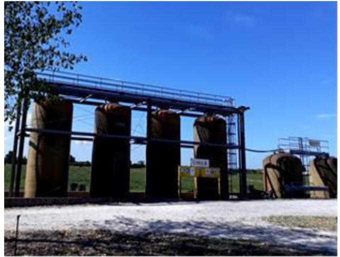
**Figura 24.** Particolare dell'impianto di raccolta percolato: cisterne di stoccaggio.
