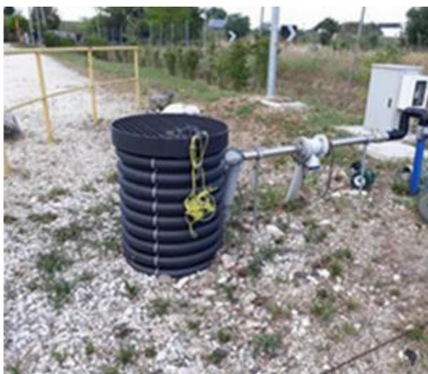
Figura 1. Particolare dell'impianto di raccolta percolato: pozzo di raccolta.
