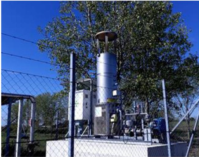
**Figura 23** Particolare dell'impianto di captazione biogas: torcia.
