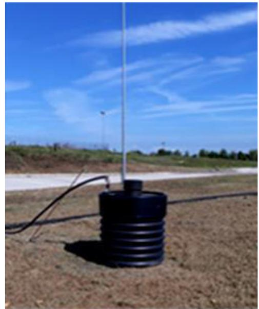
**Figura 26.** Particolare dell'impianto di raccolta percolato: pozzo di raccolta.
