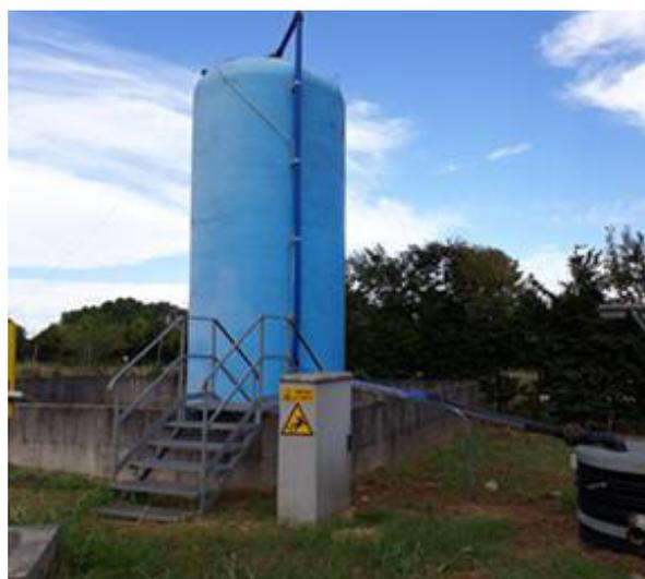
Figura 16. Particolare dell'impianto di raccolta percolato: cisterna di stoccaggio.
