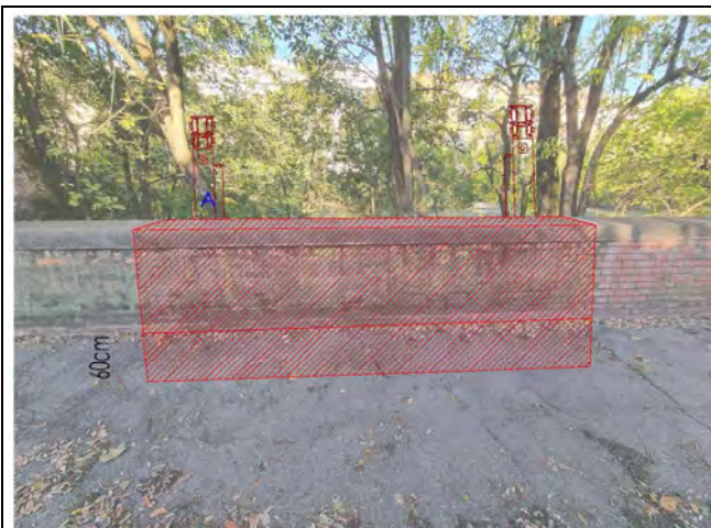
Tratto di muro da demolire
