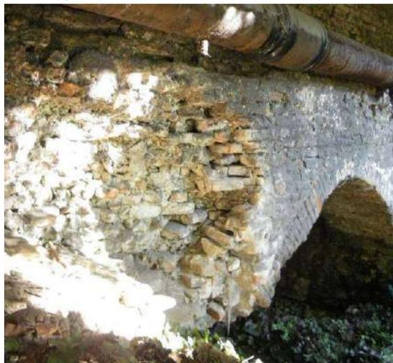
Figura 18: Particolare crollo locale di porzione di paramento
