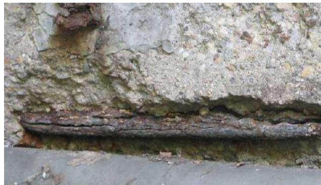
Figura 21: Particolari degrado delle armature metalliche
