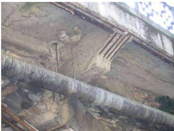
Figura 23: Particolare dissesti dell'impalcato in c.a.
