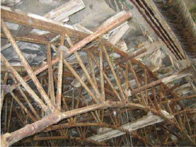
Figura 19: Particolare centinatura metallica. Si notano le precarie condizioni di stabilità degli elementi lignei di spessoramento e la rottura degli spigoli dei conci lapidei in aderenza alla nervatura in c.a.
