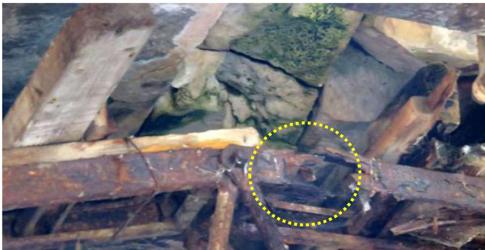
Figura 22: Particolare dissesti della centinatura metallica.
