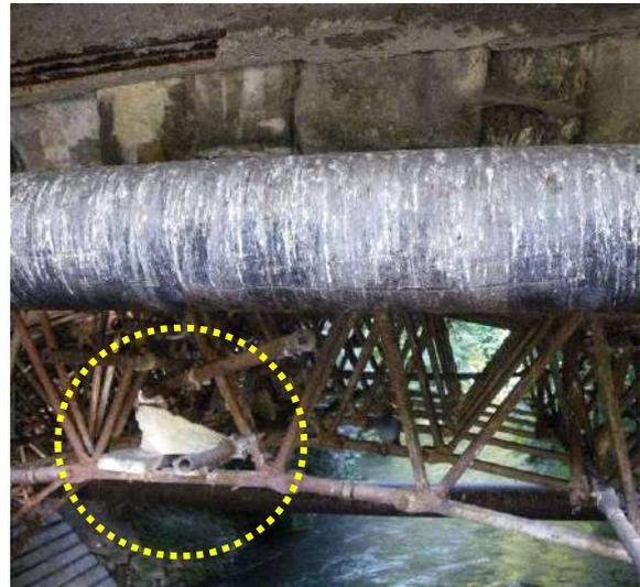
Figura 20: Particolari arcata principale. Nel cerchio viene evidenziata una porzione di conco lapideo espulsa e caduta sulle tavole sottostanti.
