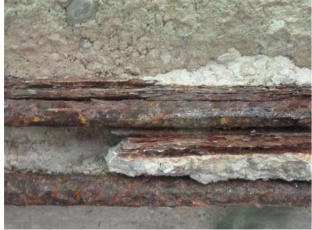
Figura 7.11 Degrado del calcestruzzo e delle barre nelle travi longitudinali
