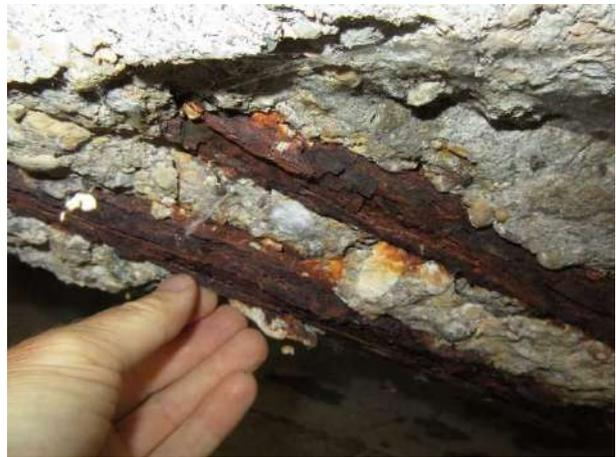
Figura 11: Particolari degrado elementi in c.a.
