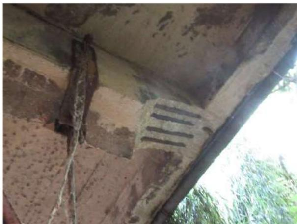
Figura 7.10 Degrado del calcestruzzo e delle barre con distacco del copriferro delle travi trasversali
