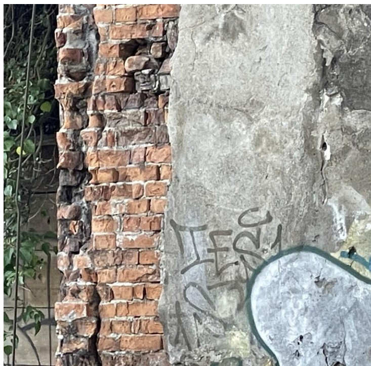
Figura 7. Fessurazione su muratura.
