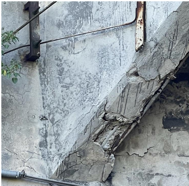
Figura 2. Degrado di una trave nella porzione orizzontale inferiore
