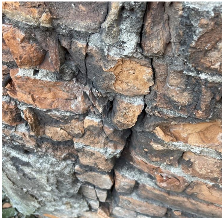
Figura 6. Particolare fessurazione su muratura.
