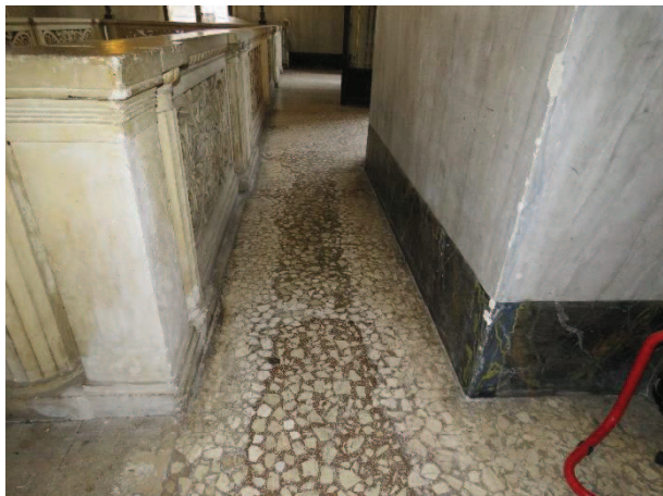
Stato di conservazione della pavimentazione in battuto veneziano
