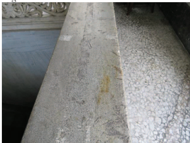
Particolare dei depositi presenti sulla balaustra
