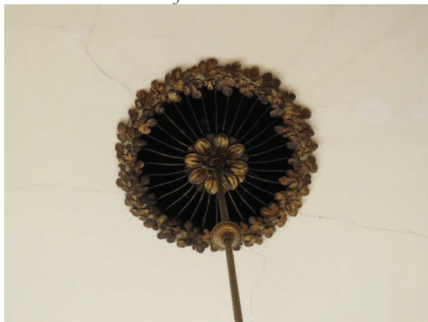
Particolare delle fessurazioni presenti sul soffitto
