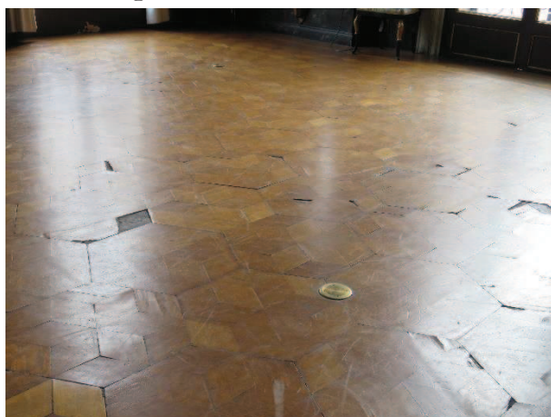
Stato di conservazione della pavimentazione lignea
