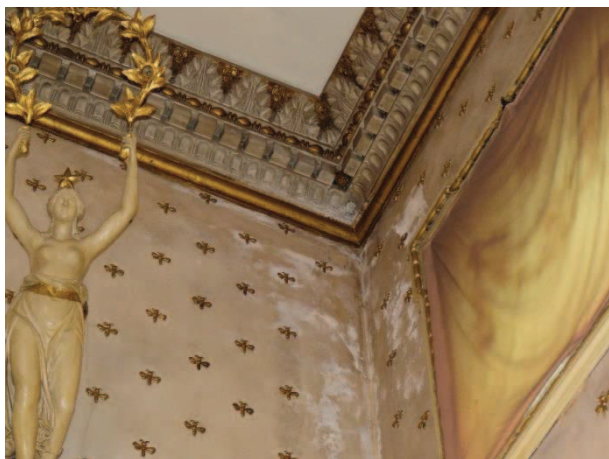
Particolare delle macchie di umidità presenti sulle murature
