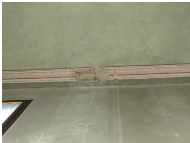
Particolare del degrado legato all'umidità di infiltrazione lungo la cornice sommitale
